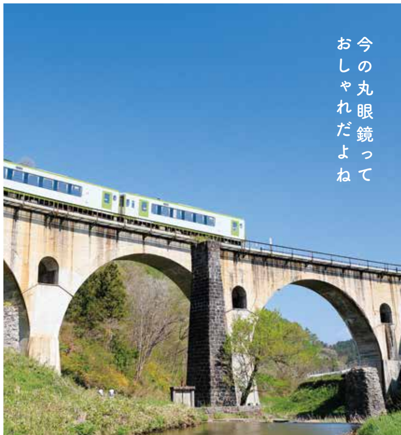
めがね橋（室守川橋梁） 遠野市
